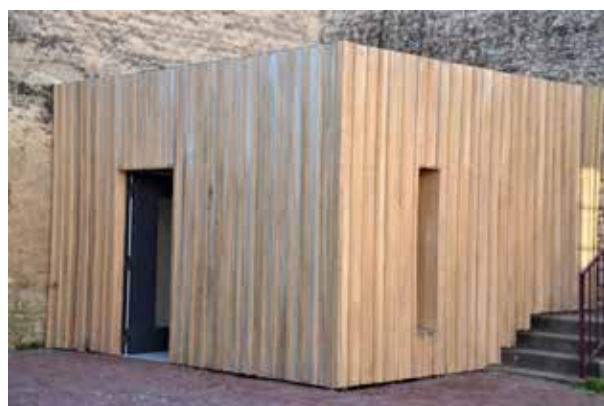
Les toilettes publiques rénovées devant la mairie
